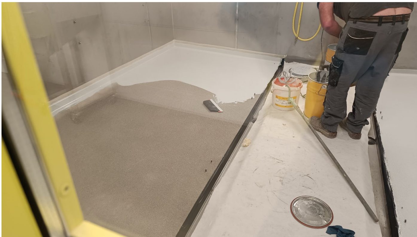
6.6-Photo adaptation enclos : adaptations diverses pour remise en œuvre des enclos sur la forme de pente crée et reprise cloison intermédiaire comprenant manipulation porte intermédiaire, profilés de calfeutrement en partie inférieure et reprise sur mesure de platines de fixation et ancrages dans les murs
