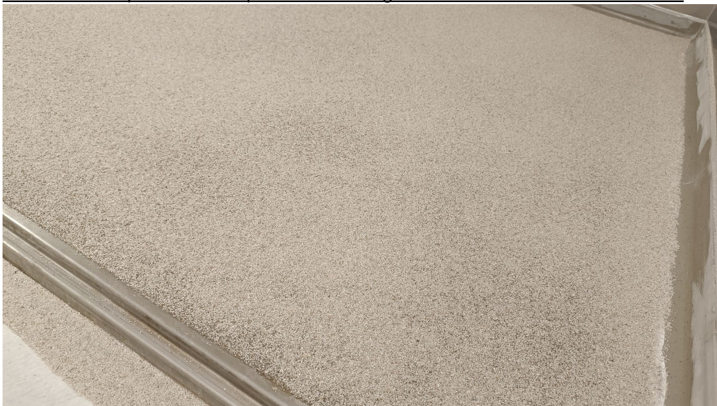
6.5-Photo complexe résine : primaire – sablage – couche de masse et fermeture
